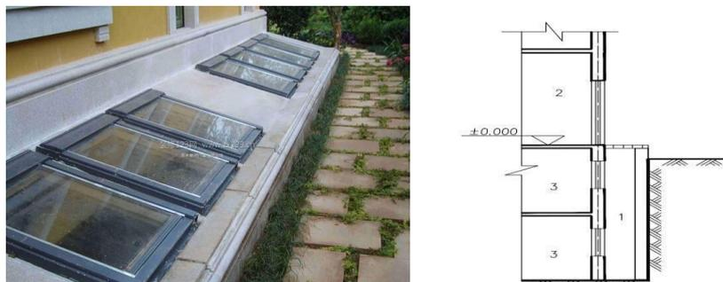
图 34 地下室采光井（1-采光井；2-地上层；3-地下室）
