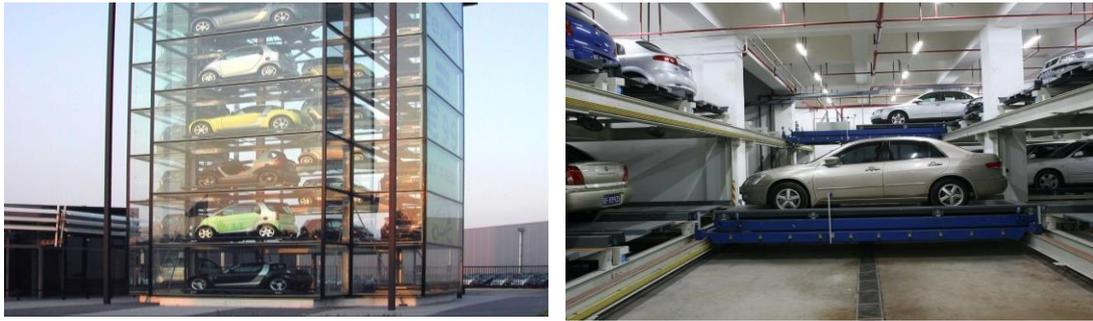
图 20 车库中的升降设备，不属于结构层，不计算分层建筑面积
